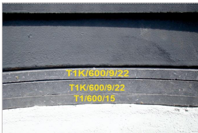
Obr. 1.17 Standardní použití prstenců systému Aquion TVR T v betonových konstrukcích zakončení jako prvek pro regulaci výšky šachty a tlumič rázů Vyrovnávací plastové prstence o výšce 15, 30, 40 mm a klínové prstence T1K/600/9/22 a T1RK/625/30/60 mm vylučují použití nespolehlivých cementových malt
