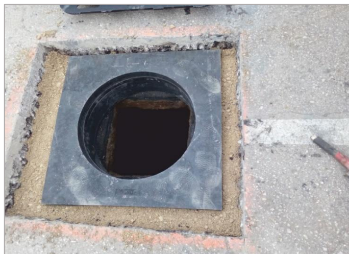
Obr. 1.8 Základová deska T04/850/620/50 položená na vyrovnávacích prstencích T1/600 a povrchovém základu, připravená pro montáž čtvercového rámu 850x850.
