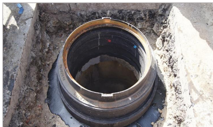
Obr. 1.4 Zakončení vstupní šachty vytvořené pomocí vyrovnávacích prstenců T1R/625 a T1/600 spolu s klínovými prstenci T1K/600/9/22. Výška regulace 24 cm. Nivelační a opravná vrstva je vytvořena na bázi rychle tuhnoucí polyesterové výplňové hmoty.
