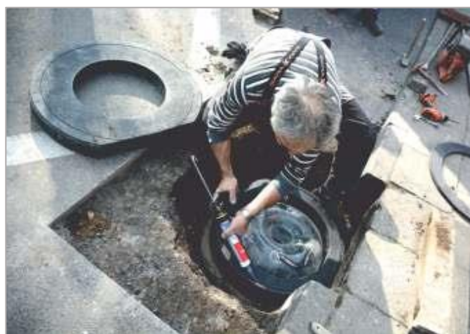
Obr. 1.31 Aplikace polymerních hmot mezi prvky opravovaného zhlaví uliční vpusti.
