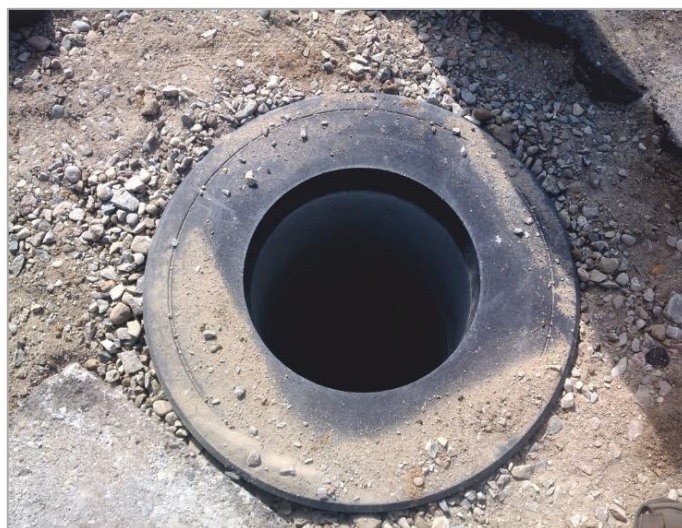
Obr. 1.6 Adaptér TX/765/410 připravený pro montáž uliční vpusti 400x600, posazený na betonové skruži uliční vpusti DN 450.
