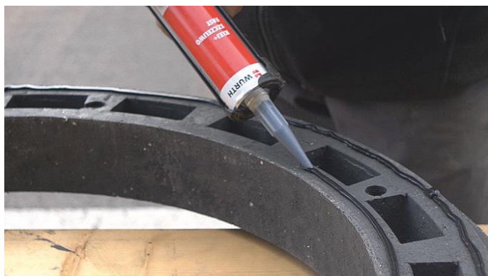
Aplikace těsnícího polymerového tmelu na spodní plochu vyrovnávacího prstence
