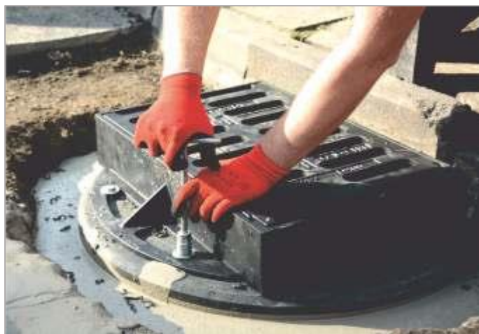
Obr. 1.30 Silniční vpust 400x600 mm s rámem 3/4, namontovaná na adaptéru TX/765/410/80. Vpust je přikotvena k adaptéru. Adaptér zajištěný zálivkovou hmotou nalitou okolo podkladních prstenců a adaptéru. Zálivková hmota je základem pro povrchové vrstvy vozovky.
