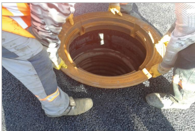
Obr. 1.39 Samonivelační poklop instalovaný na zhutněném asfaltovém povrchu s použitím komponentů Aquion TVR T pro konstrukci zhlaví plastové šachty Tegra 600. Jelenia Góra, silnice – S-3.
