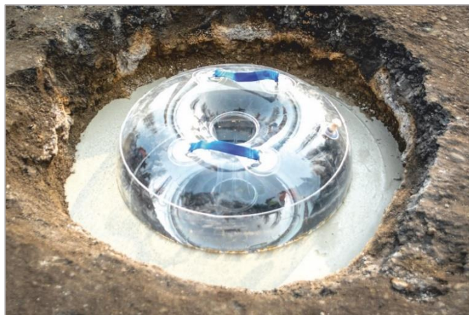
1 Obr. 1.12 Aplikace rychle tuhnuocí vyrovnávací a opravné směsi na bázi cementů. Velmi rychlý čas tuhnutí a tvrdnutí, možná okamžitá montáž prvků systému Aquion TVRT.
