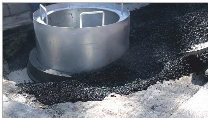
Obr. 1.23 Příprava konstrukce podporující samonivelační poklop z prvků systému TVR T a asfaltové hmoty. Teplota asfaltové hmoty (170°C) nemá vliv na parametry vyrovnávacích a vodících prstenců během zabudování.
