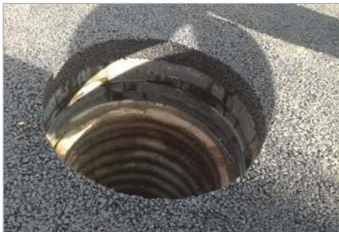
Obr. 1.38 Zhlaví šachty Tegra 600 z prvků systému Aquion TVR T (vyrovnávací prstence T1/700/50, vodící prstenec TXS/700/80), připravená pro instalaci samonivelačního poklopu. Jelenia Góra-S-3.
