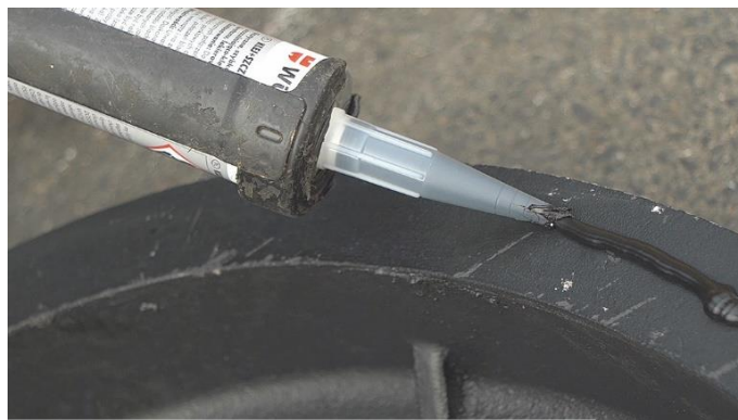
Aplikace těsnícího polymerového tmelu a spojovací hmoty na dolní povrch rámu poklopu
