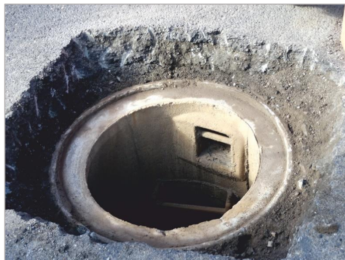
1 Obr. 1.11 Konstrukce zúžení betonové kanalizační šachty DN 625 v dobrém technickém stavu splňující podmínky pro montáž zhlaví šachty z prvků systému TVRT. Malá poškození a nerovnosti povrchu budou vyrovnány vyrovnávací vrstvou.
