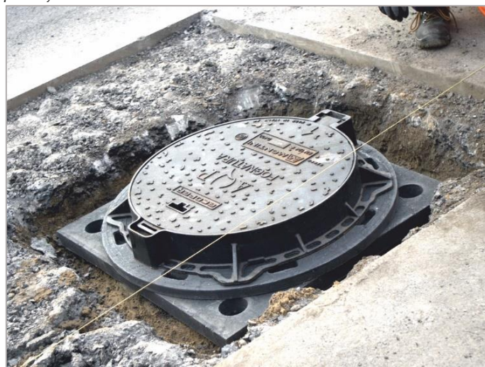
Obr. 1.2 Rekonstrukce uložení kanalizačního poklopu na bázi vyrovnávacích prvků systému TVR T
