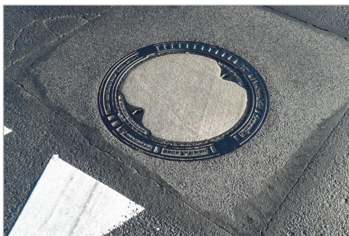
Obr. 1.37 Plovoucí poklop uložený pomocí vyrovnávacích prstenců T1/700 a vodícího adaptéru TXS/710/80 umožňující dobrou instalaci samonivelačního poklopu. Legnica silnice S-3, křížový pojezd po poklopu, zatížení na pás Kr. 4. (336-100 pojezdů jízdní pruhu/den osa 100 kN) po 6 letech provozu.
