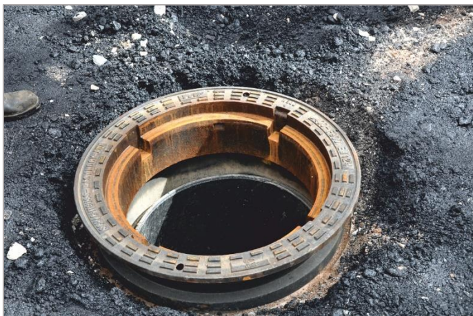
Obr. 1.5 Adaptér/vodící prstenec TXS/635/80 nesoucí samonivelační poklop EASY LOCK během montáže.
